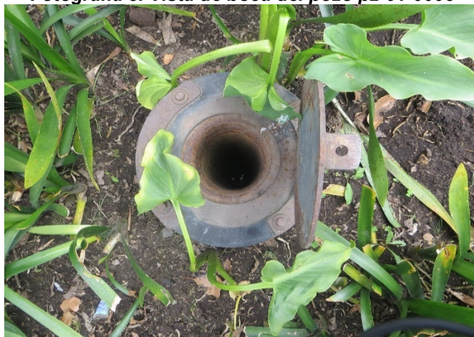
Fotografía 3. Vista de boca del pozo pz-01-0005
