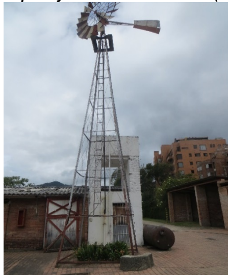
Fotografía 4. Ubicación del pozo y sistema de extracción (molino- ambos en desuso)
